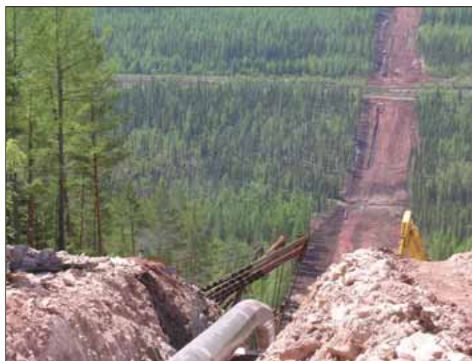
Строительство участка, представленного на чертеже профиля
