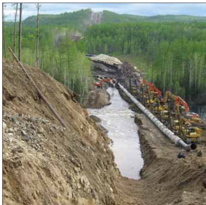
Строительство подводного перехода реки Уркан
